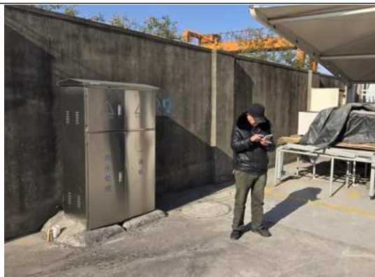
地下雨水收集池（兼做事故应急池）
